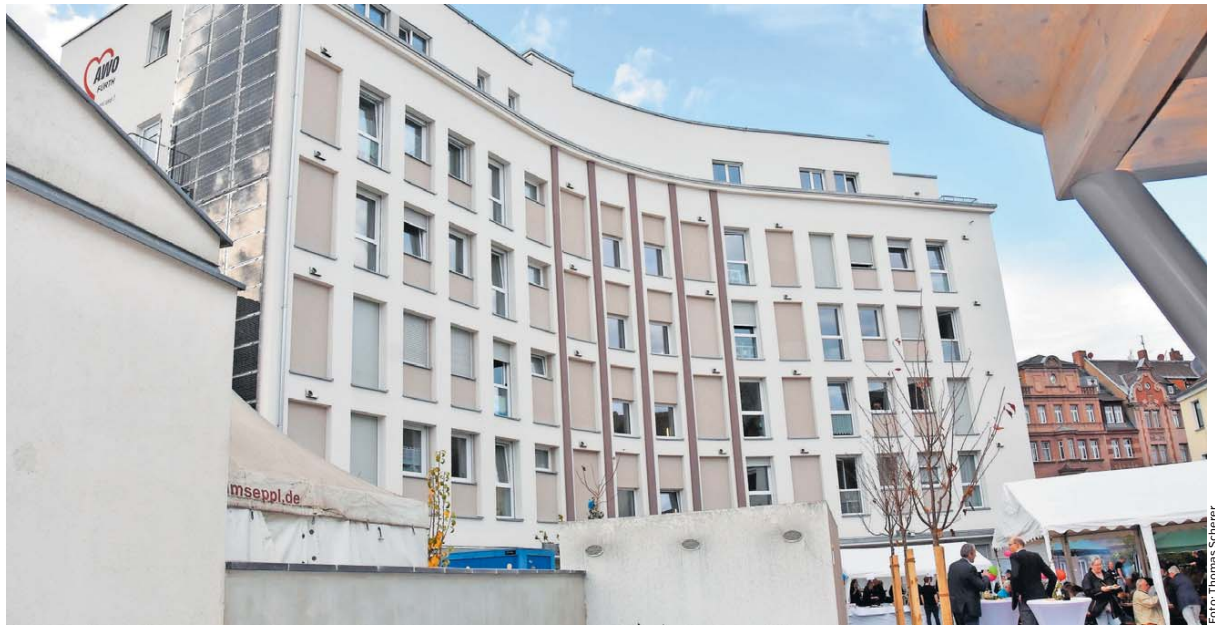
Dieser Tage wurde die endgültige Fertigstellung des neuen Quartiers in dem umgebauten Firmenkomplex gefeiert. Die neuen Außenanlagen laden zur Begegnung ein.
